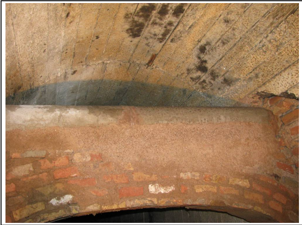
Foto 61: Posterior canonada que va destruir part del refugi antiaeri, al tram del mig del passatge Toledo.
