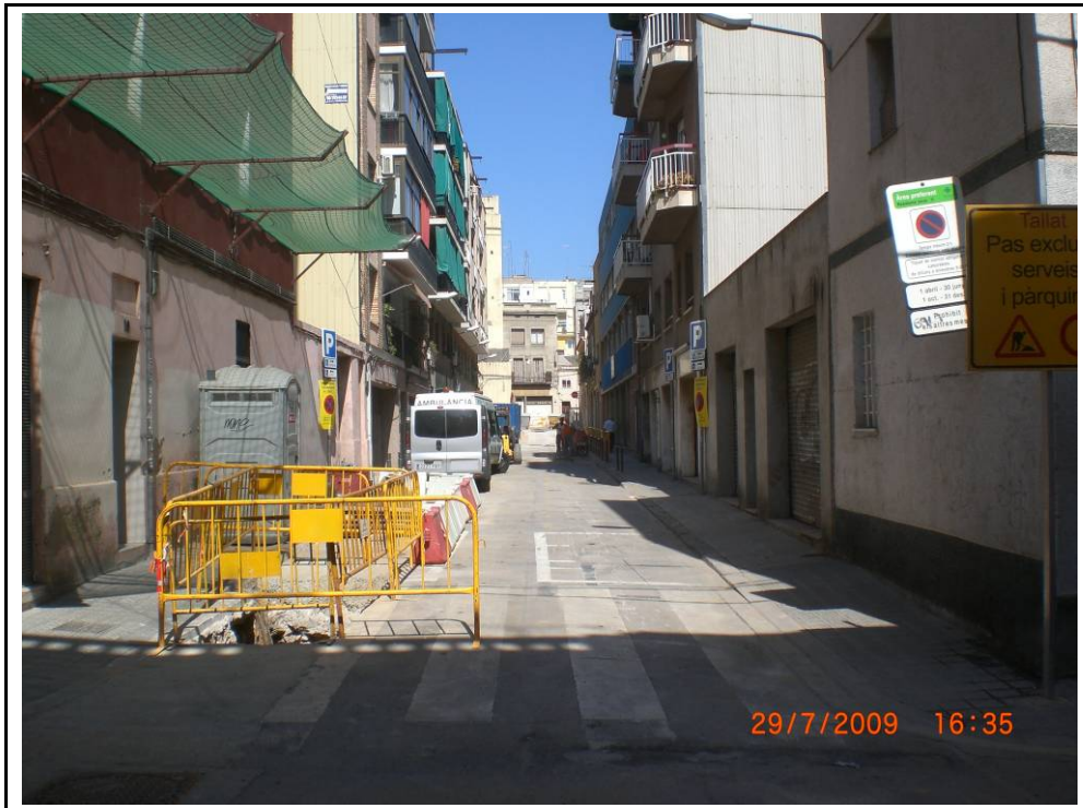
Foto 72: Estat final de l'obra constructiva al passatge de Toledo.
