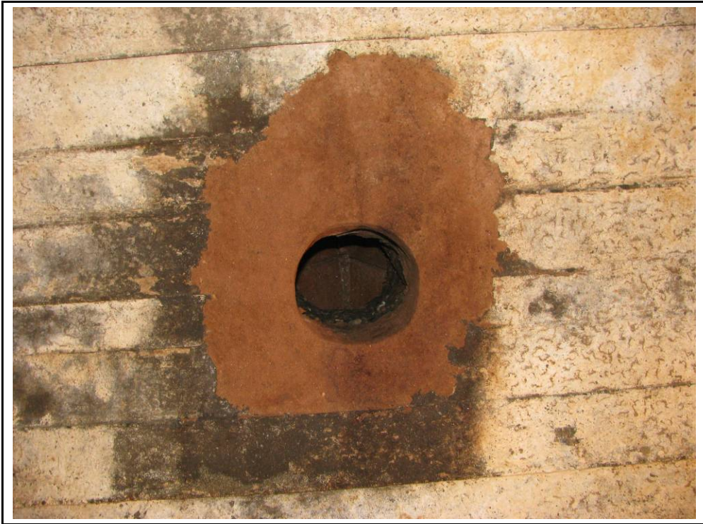
Foto 15 Pou de ventilació 4.
