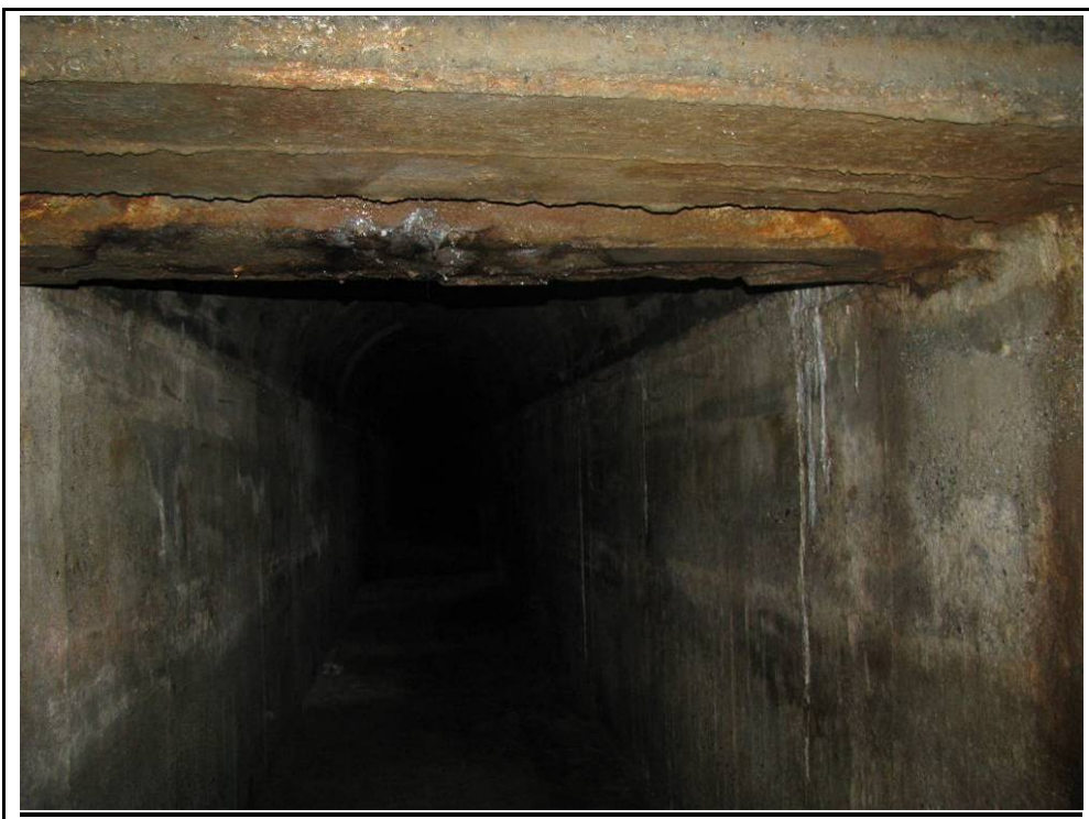
Foto 59: Cruïlla entre el carrer de Toledo i el passatge de Toledo, amb la canonada incorporada a la galeria.
