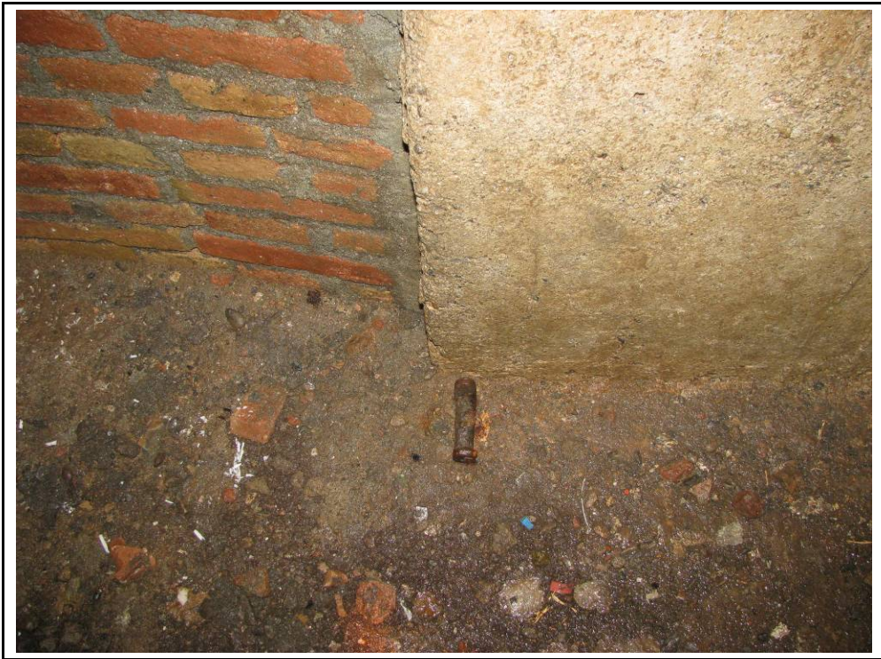
Foto 4: Detall del roda peus de la porta corredora de fusta que hi havia al refugi antiaeri de l'accés 1.
