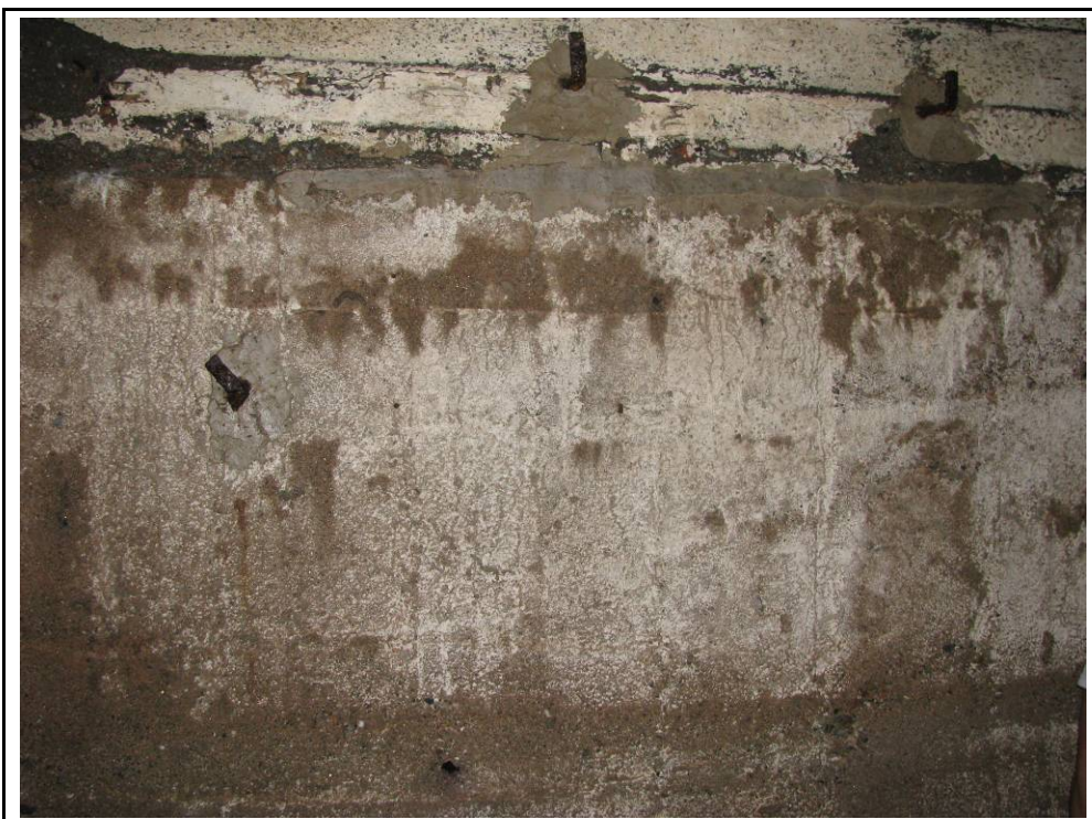
Foto 56: Sistema per enganxar el sistema elèctric.
