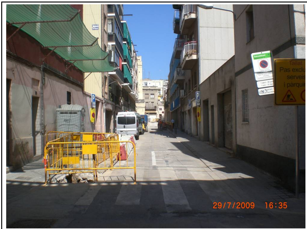
Foto 73: Estat final de l'obra constructiva al passatge de Toledo.
