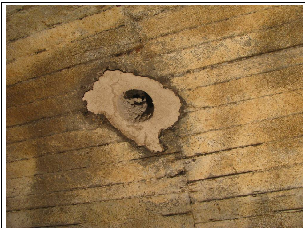
Foto 12: Pou de ventilació 1.
