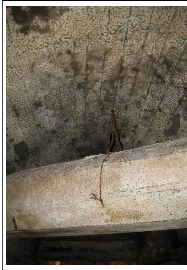
Foto 58: Restes de filferro per subjectar el clavegueram incorporat dins del refugi. En aquesta biga anava el sistema d'enllumenat.
