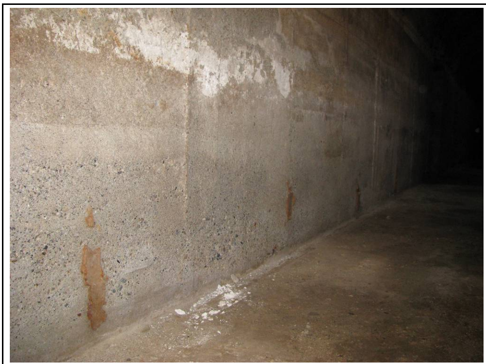
Foto 53: Restes d'argamassa per subjectar els bancs de fusta.
