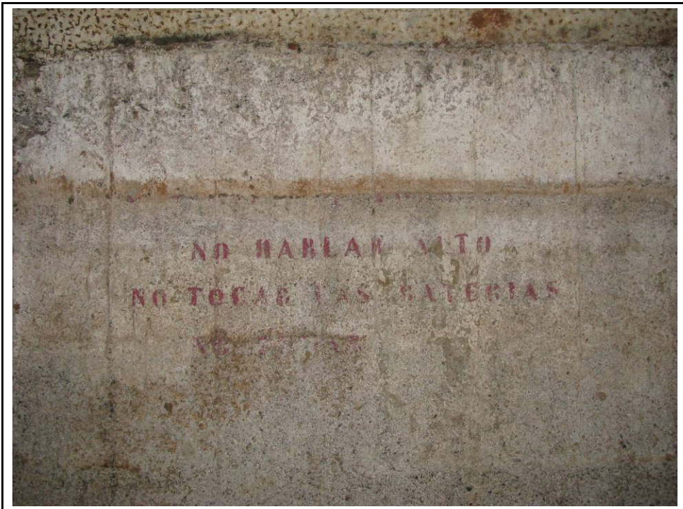
Foto 521: Pintada 14, realitzada en castellà: NO HABLAR ALTO / NO TOCAR LAS BATERIAS / NO FUMAR.
