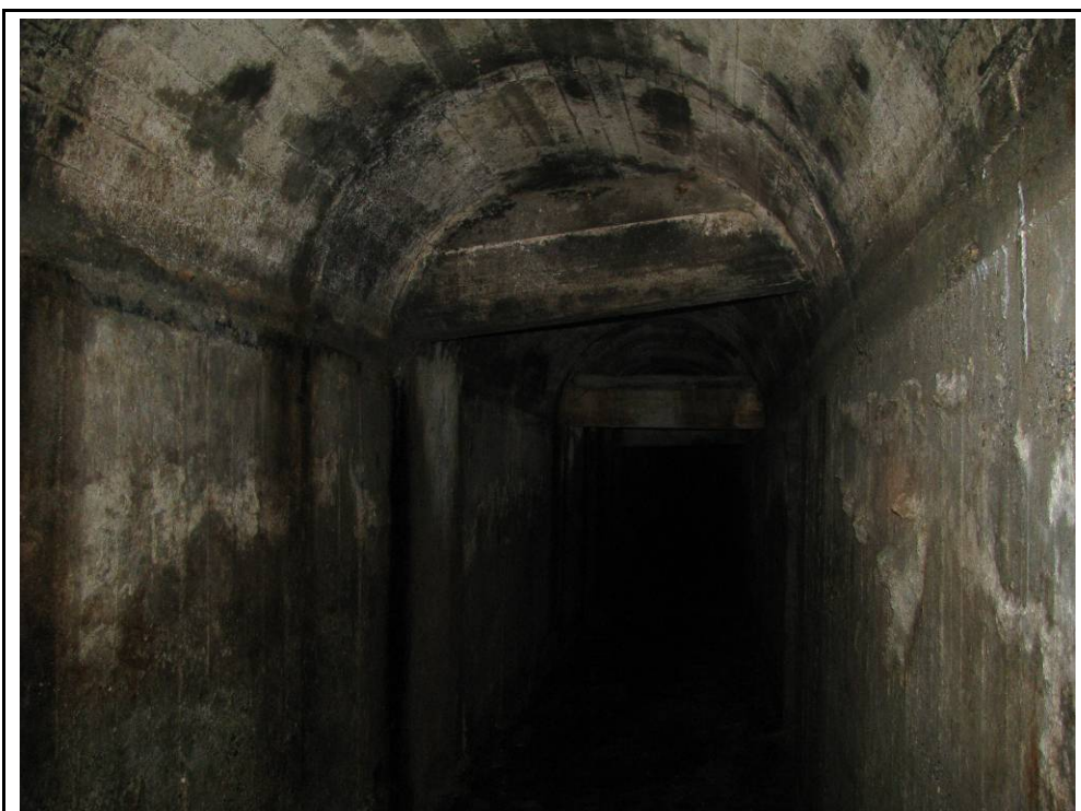
Foto 60: Vista de la galeria al tram del carrer de Toledo on es veuen les canonades incorporades i encofrades dins del refugi.
