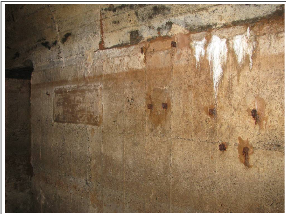
Foto 36: Cartell o rètol 5, al costat del sistema elèctric.
