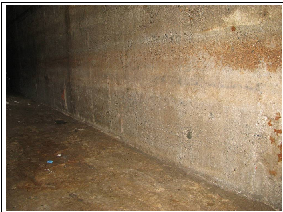
Foto 54: L'argamassa o ciment tenen una equidistància d'un metre aproximadament.
