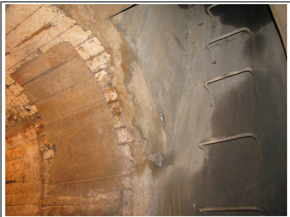
Foto 10: Pou claveguera 2. L'accés de l'esquerra, que es troba tapiat, es l'entrada inicial al refugi, que posteriorment es va modificar.
