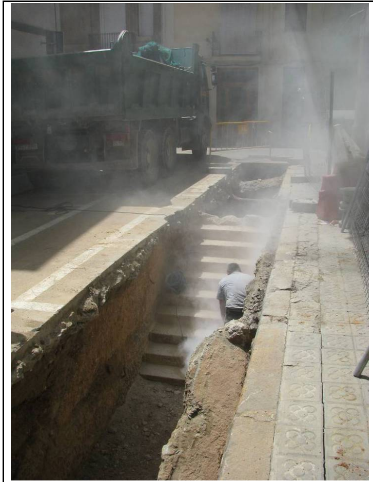
Foto 68: Control arqueològic del desmuntatge d'una part de l'escala per a la realització de la canonada actual.
