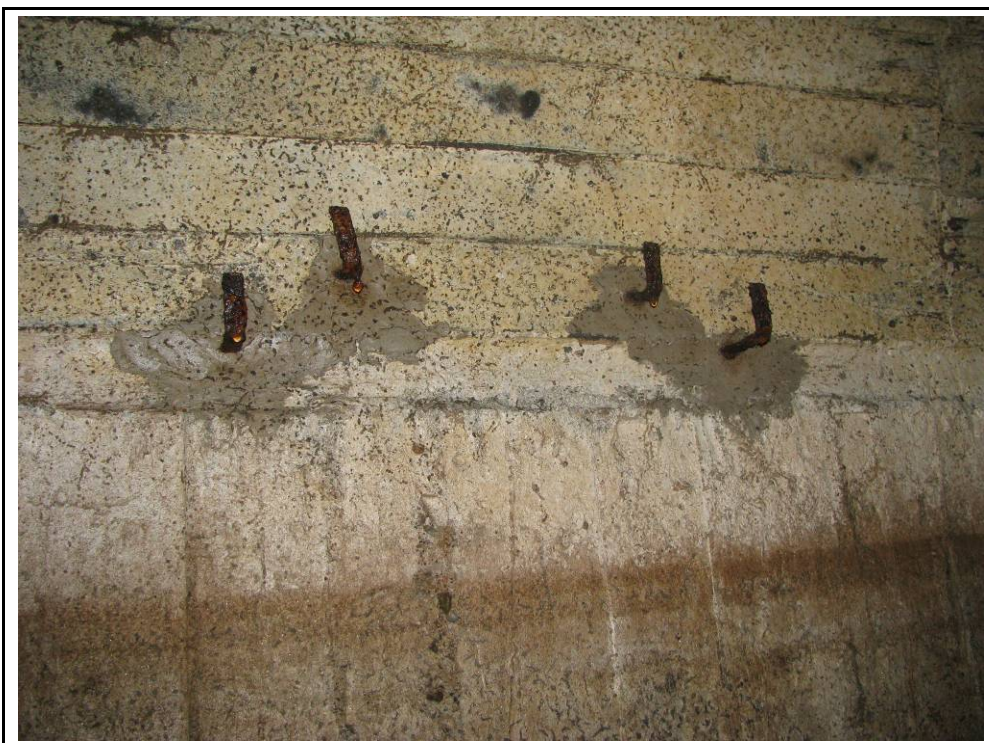
Foto 55: Anellatge per a col·locar el generador.
