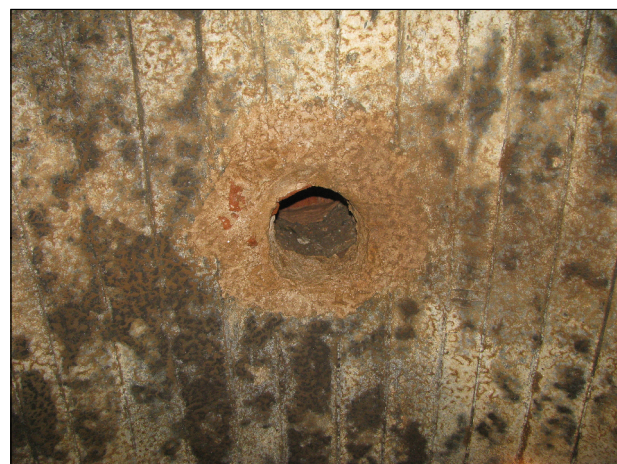
Pou de ventilació 2.
