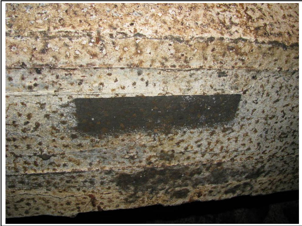
Foto 57: Detall del sistema utilitzat per a la il·luminació. Es tracta d'una empremta de les restes d'una fusta on anaven els aïllants. Present en les canonades.
