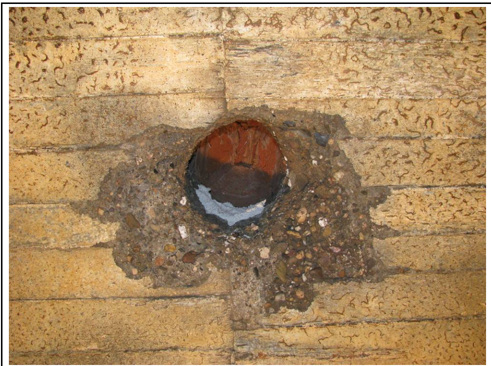
Foto 16: Pou de ventilació 5.
