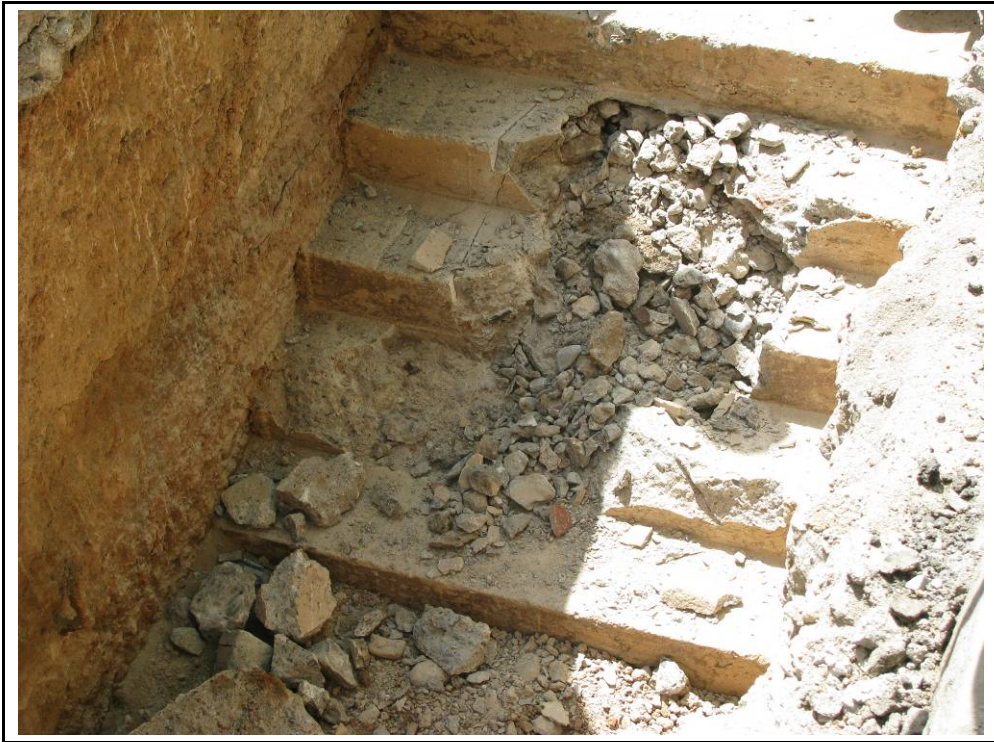
Foto 69: Treballs constructius de la perforació d'una part de l'escala per a col·locar el nou sistema de clavegueram.
