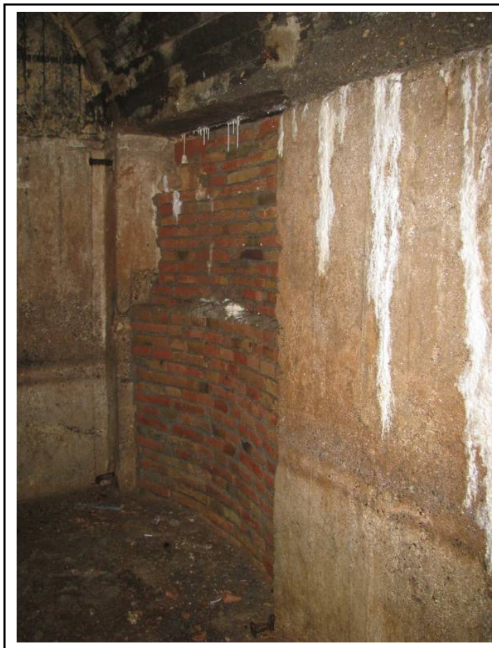
Foto 3: Accés o entrada al refugi tapiada per a la seva reutilització com a clavegueram.
