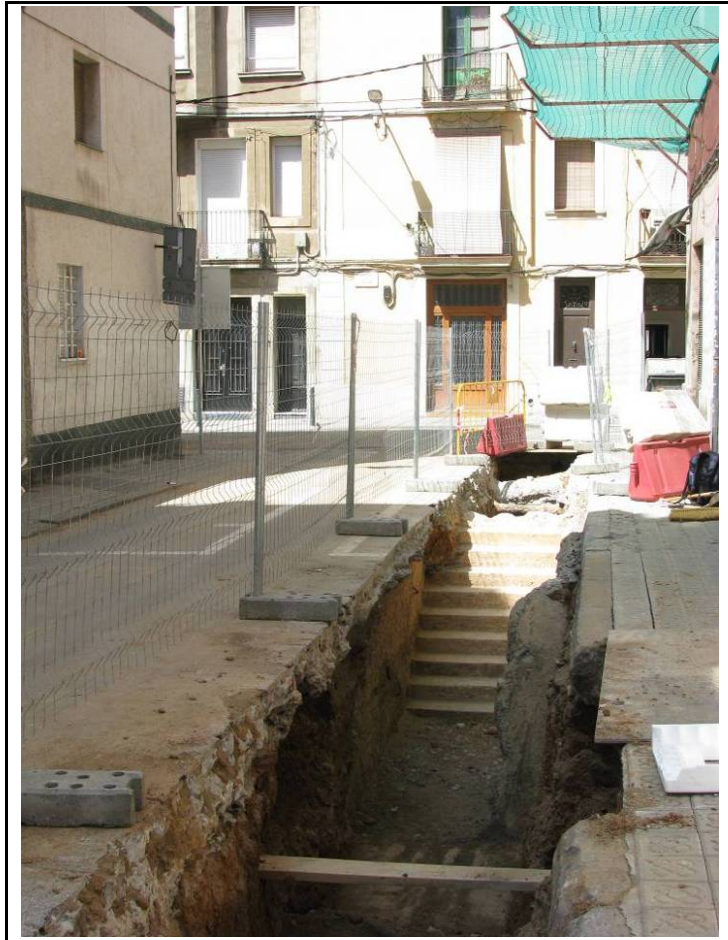
Foto 66: Vista general de l'entrada al passatge de Toledo.
